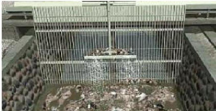
**Gambar 2. 4** Trash Rack Elektro Mekanik
